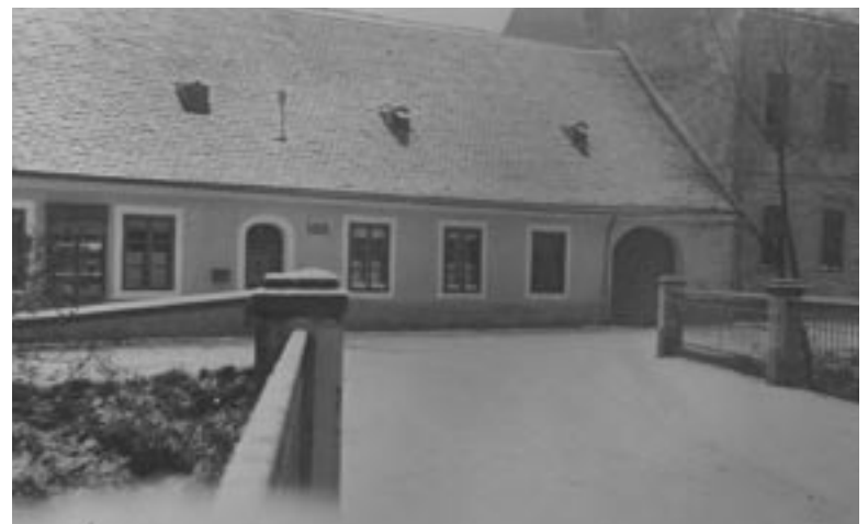
Es war einmal: Das Haus Marktplatz 2 vor dem Umbau, als es noch die Lackiererei beherbergte.
